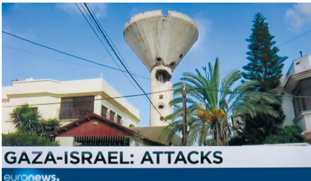
Der bei Angriffen getroffene Wasserturm
